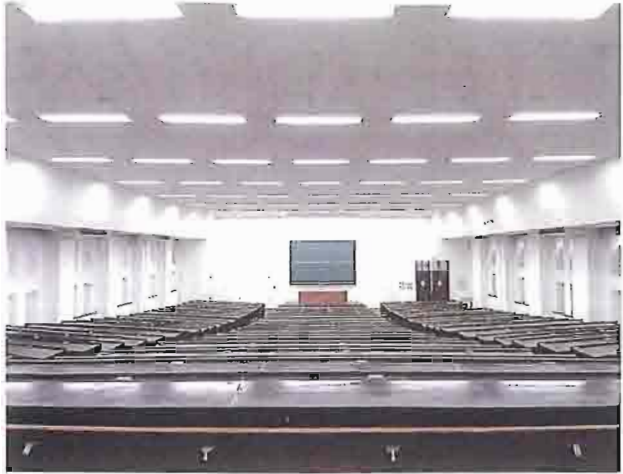
本館内の講堂は、受験会場としてニュースなどによく登場する。耐震補強工事の一環として、窓枠に耐震補強パネルを設置した。
